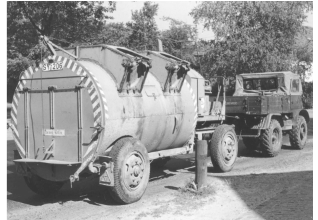
Bild links: Ein Übergangsmodell: Hoyas städtischer Trommelmüllwagen in den 1960er Jahren. Zwei Einschüttvorrichtungen waren für die Entleerung genormter Ringeimer vorgesehen, zwei weitere machten es möglich, auch improvisierte Abfallbehälter auszuleeren und kleineres Sperrgut einzuwerfen.
