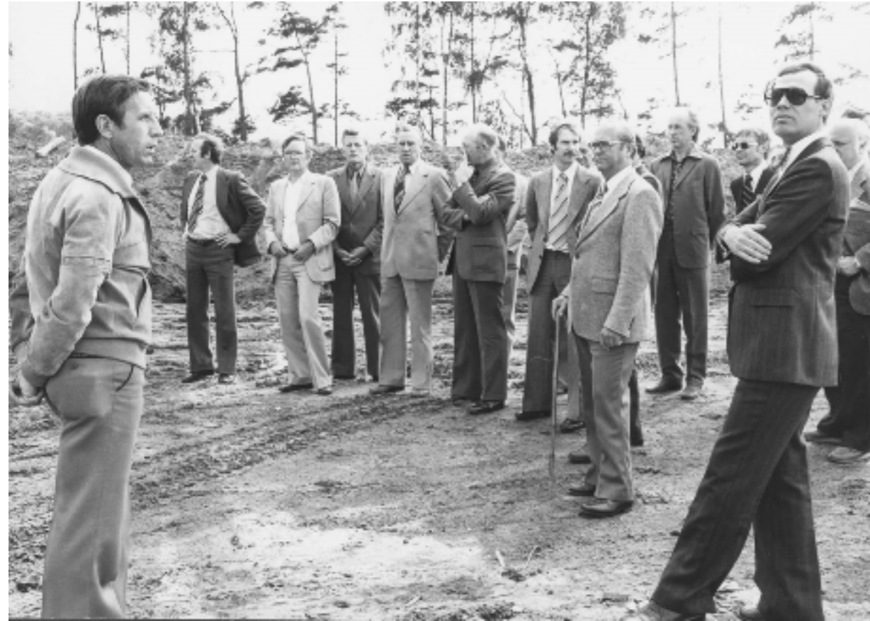
15. Juni 1978: Die Zentraldeponie in Bassum-Wedehorn wird offiziell ihrer Bestimmung übergeben. Vorn im Bild: Betriebsleiter Horst Brümmer (links) und Oberkreisdirektor Hans-Michael Heise (rechts)
