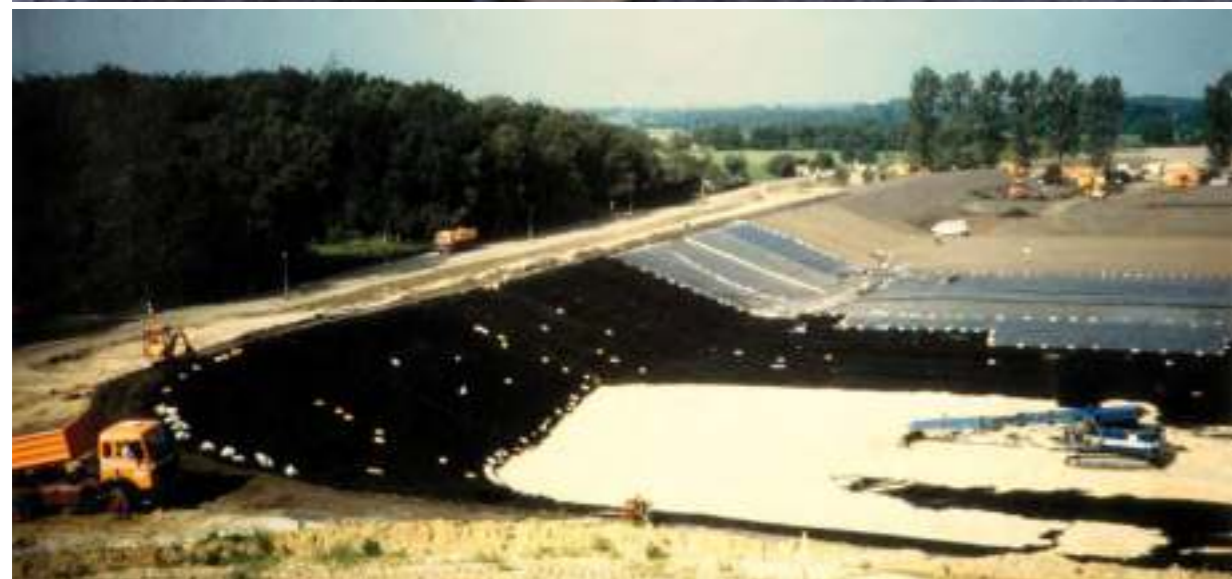
Bild oben: Bau des 5. Schüttabschnittes auf der Zentraldeponie. Spezialmaschinen verdichten die Basisabdichtung.
