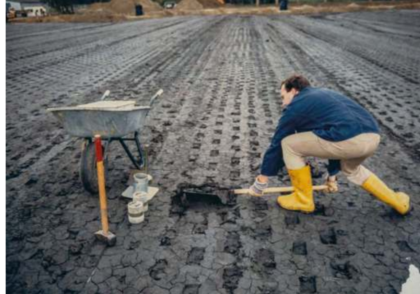
Bild links: Der Bau der Deponie-Basisabdichtung wurde begleitet von ausführlichen Prüfungen des in mehreren Schichten aufgetragenen Tonmaterials.
