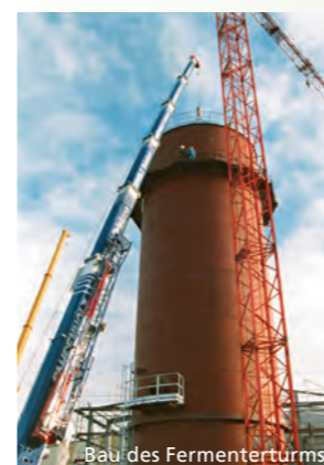
Bau des Fermenterturms
