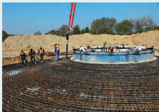
Bau des Stahlbeton-Sockels
