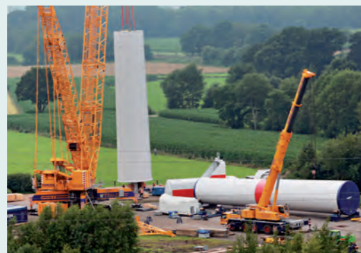
Die Stahlrohre werden montiert
